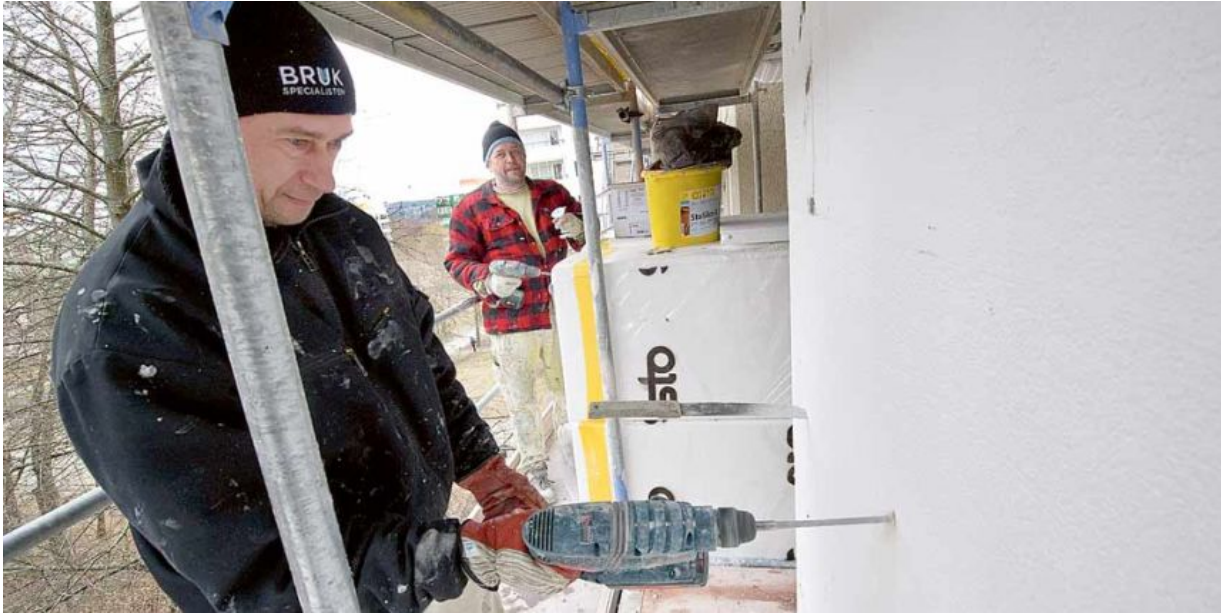
Botkyrkabyggens lägenheter måste totalrenoveras. Några våningar upp på Alhagsvägen monterar Viktor Korshunov och Roger Andersson isolerande frigolit på ytterväggarna.
